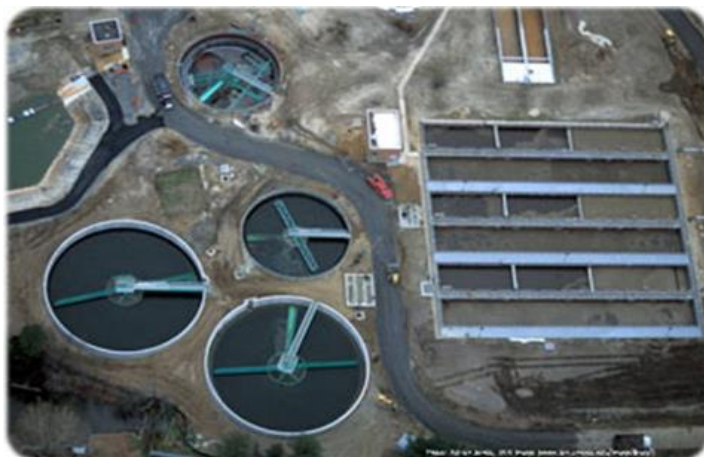
Figure 3-14 : Usine de traitement d'eau (d'après European Environment Agency).
